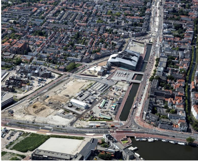
Station en tunnel vanaf het zuiden
