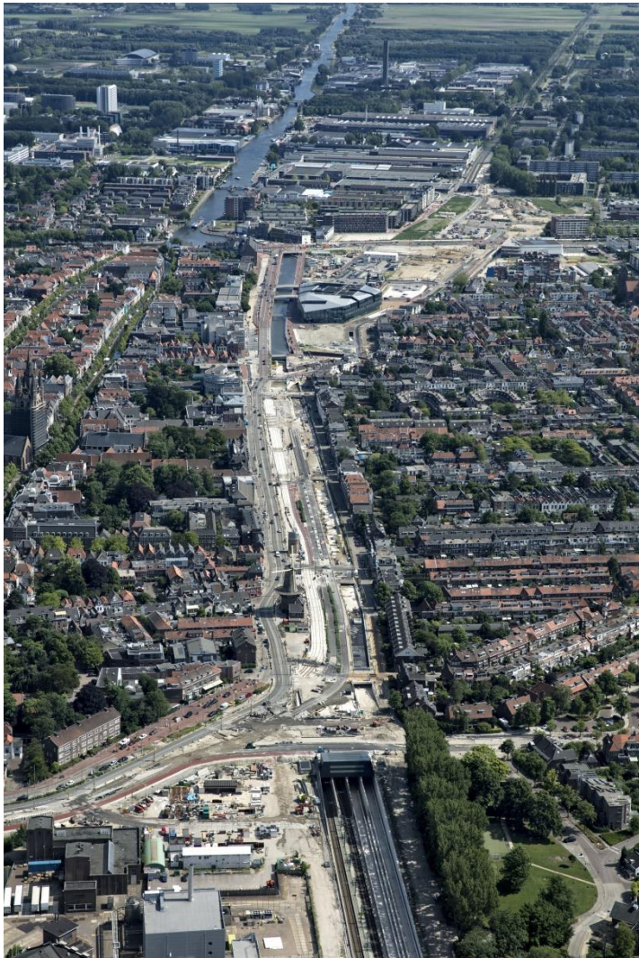
Tunnelingang vanaf de noordkant
