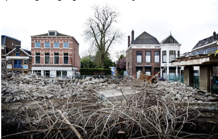
Sloop van het viaduct
